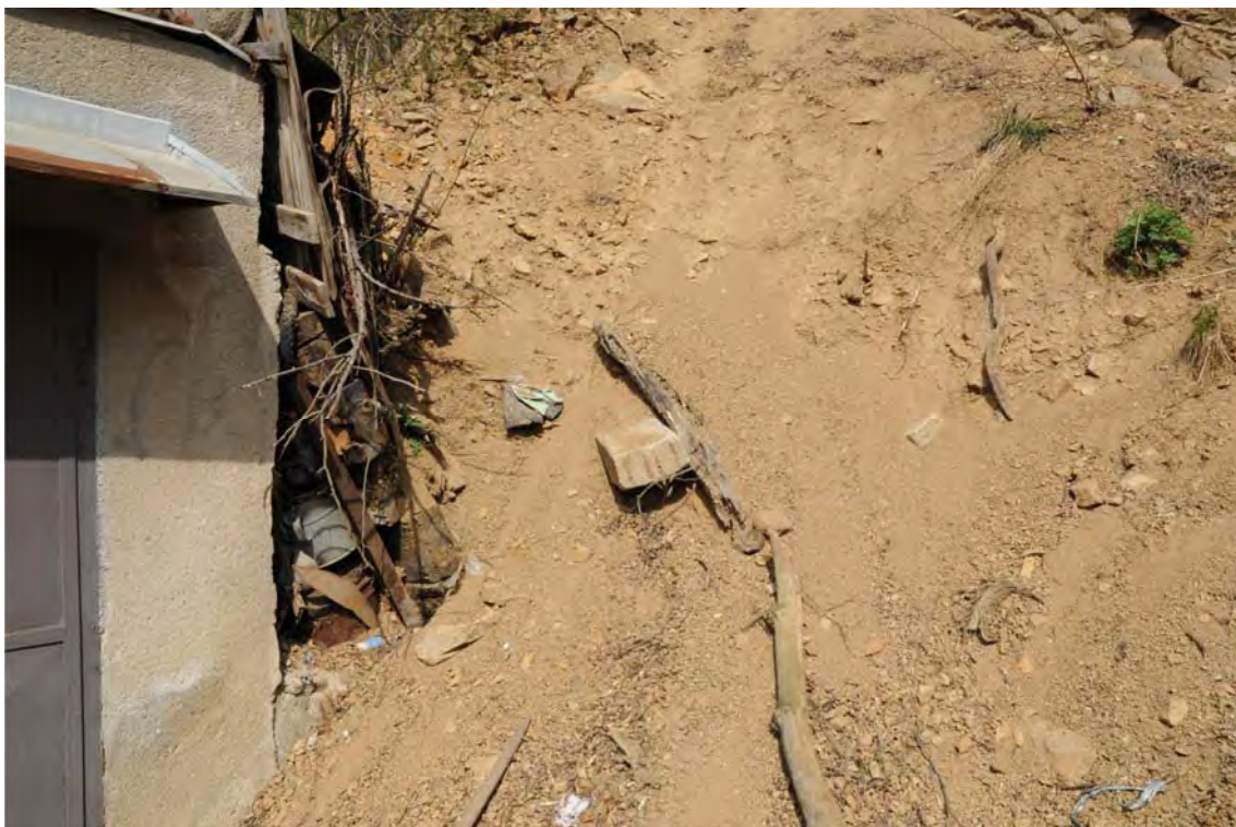
Obr. 3. Pohled na prostor těsně za garážemi se zcela zasypnými provizorními prvky pro zachytávání bloků a kamenů. Foto O. Krejčí 11. 4. 2015.
