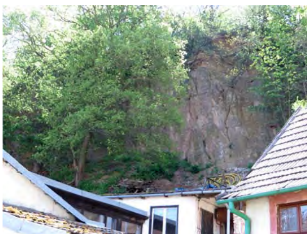
Obr. 3. Lomová stěna za domy č. p. 47a–47b. Skalní opady se akumulují do prostoru mezi skalní stěnou a rodinnými domy. Foto H. Gilíková, duben 2015.
