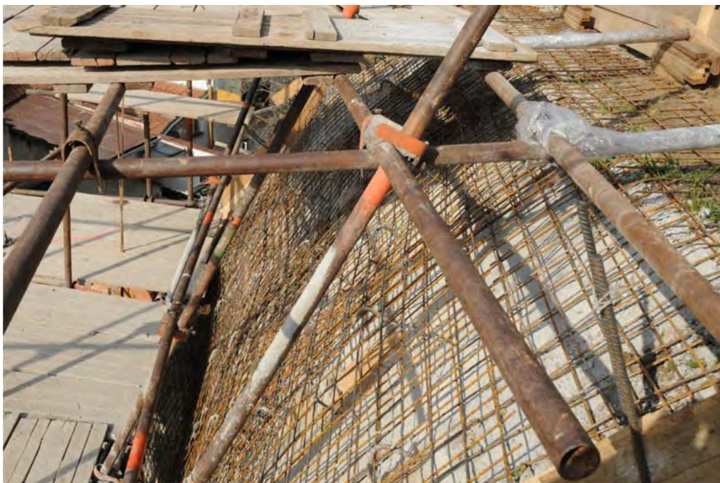
Obr. 16. Výstavba stabilizačních prvků za domem v ulici U Smyčky 6. Foto O. Krejčí, duben 2015.
